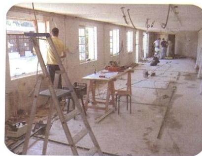
Travaux dans le réfectoire de l'hôtellerie
